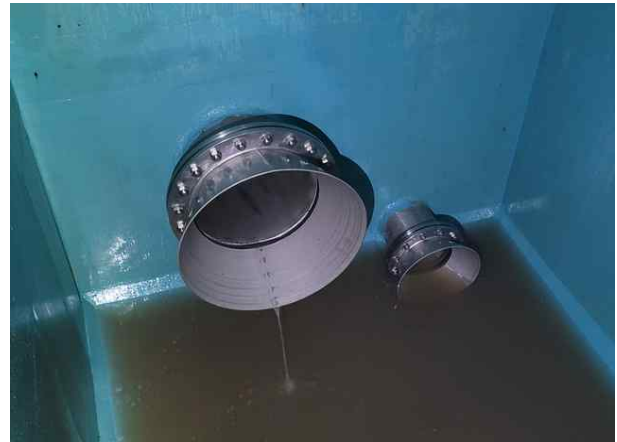
손상내용 2지 유출배관 양호 손상원인 -
