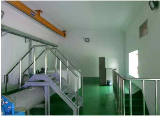
유입밸브실 내부 전경
