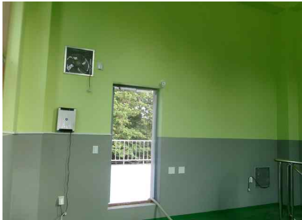
손상내용 검수실 내부 양호
