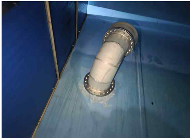
손상내용 1지 유입배관 양호 손상원인 -
