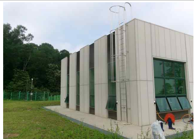
손상내용 검수실 외부 양호
