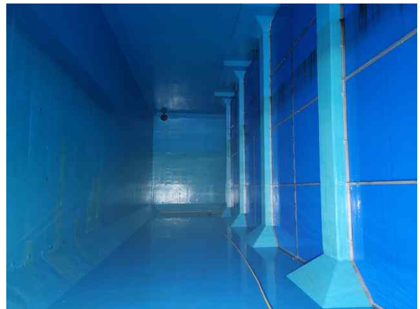
배수지 2지 내부 전경
