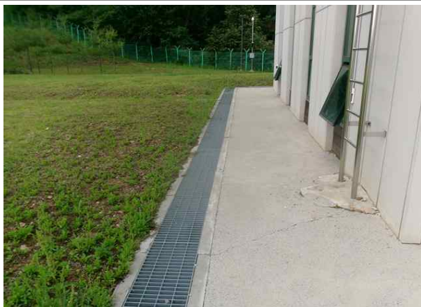
손상내용 검수실 외부 양호
