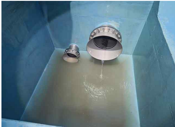
손상내용 1지 유출배관 양호 손상원인 -
