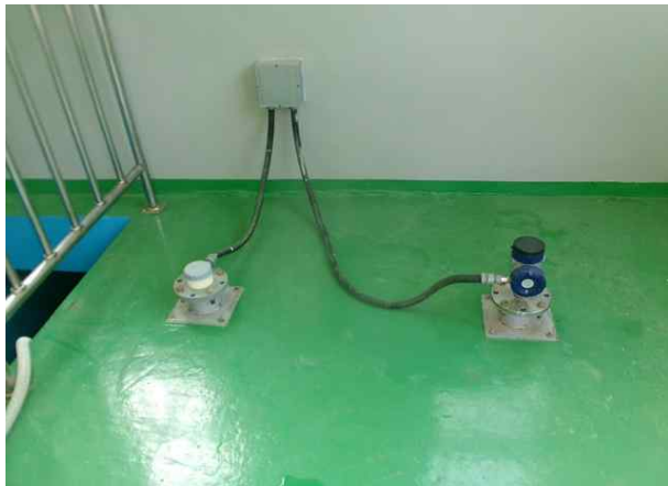
손상내용 검수실 내부 양호
