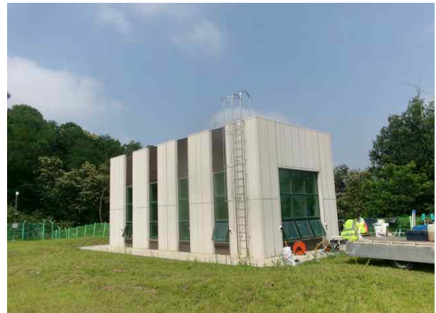
손상내용 검수실 외부 양호
