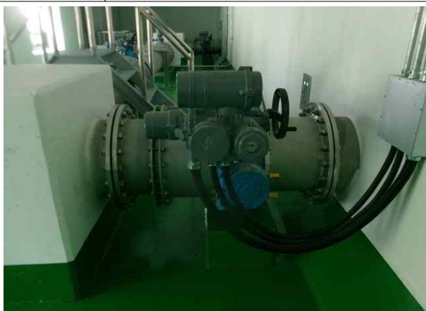
손상내용 유입밸브실 배관 양호 손상원인 -
