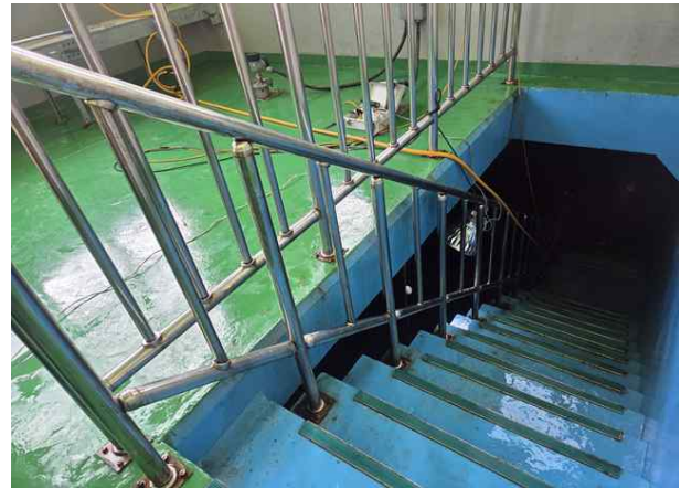
손상내용 검수실 내부 양호
