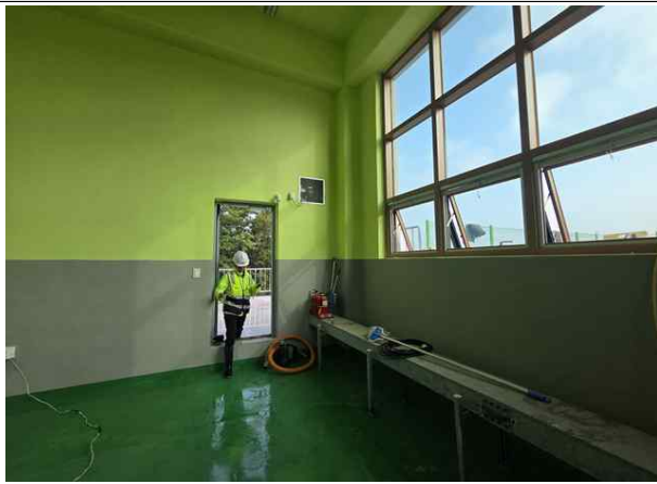
검수실 내부 전경
