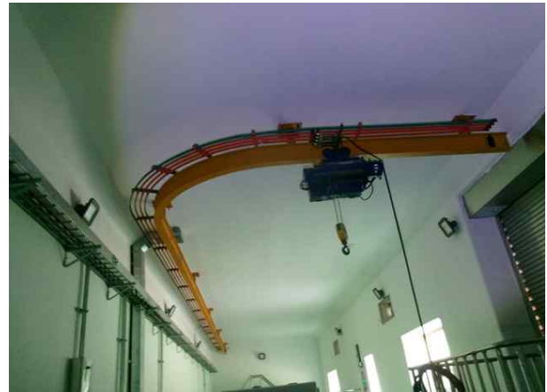
손상내용 유입밸브실 내부 상부슬래브 양호 손상원인 -
