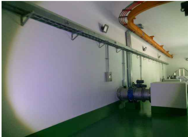
손상내용 유입밸브실 내부 벽체 양호 손상원인 -
