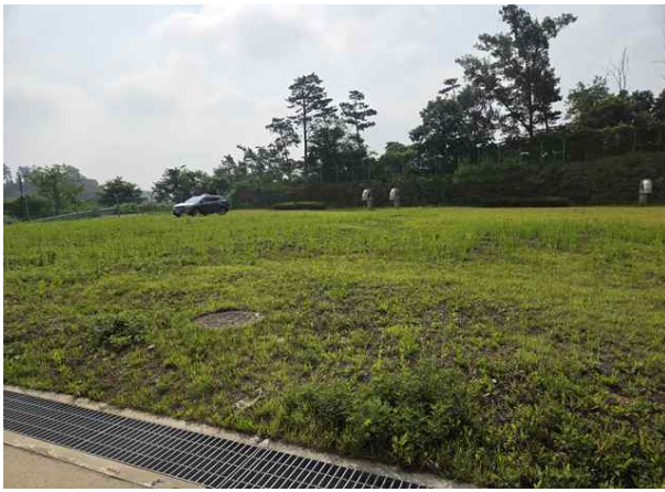
배수지 상부 현황
