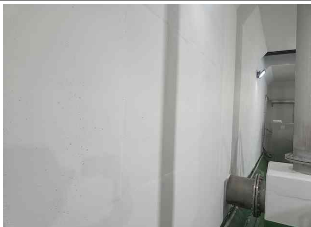
손상내용 유출밸브실 내부 벽체 양호 손상원인 -
