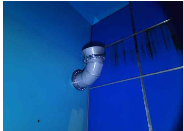
손상내용 2지 유입배관 양호 손상원인 -
