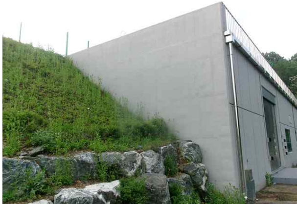
손상내용 유입밸브실 외부 양호 손상원인 -
